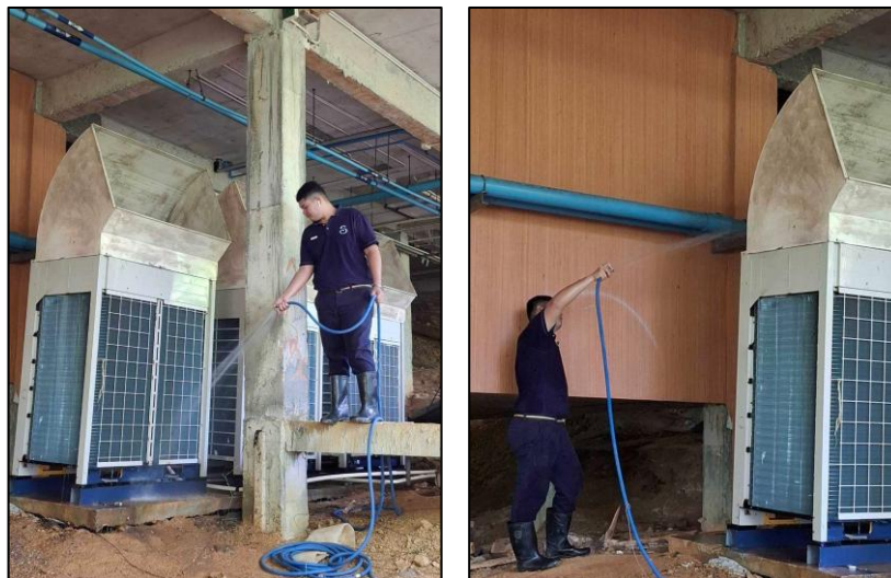
รูปภาพที่ 2.2 การทำความสะอาดเครื่องปรับอากาศ
